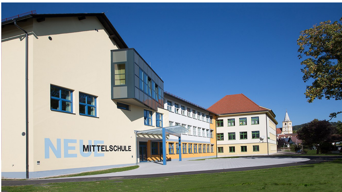
Neu saniertes Gebäude der NMS
